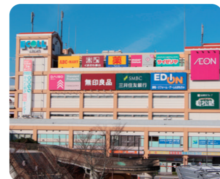
エコール・リラ (開業:1992年)兵庫県神戸市北区
